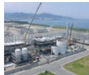
愛媛工場で建設中のメチオニン製造設備
