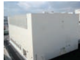
大阪工場のArFレジスト製造設備建物
