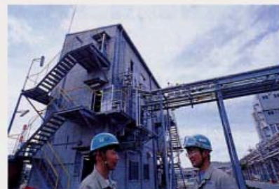
塩酸酸化の試験製造設備
