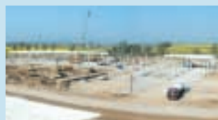
ポーランド新会社の建設現場
