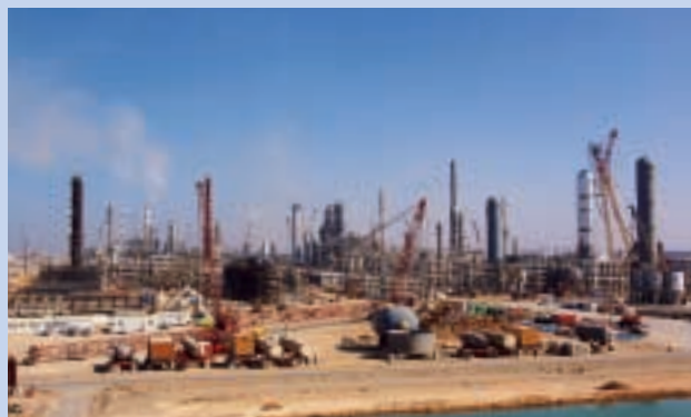
順調に進む建設工事の様子
