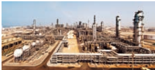
ペトロ・ラービグ社が現在運営する統合コンプレックス
