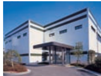
千葉工場の化合物半導体材料の製造プラント
