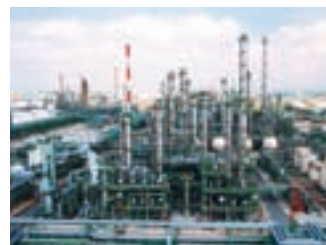
シンガポールのプラントの全景
