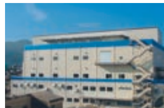
愛媛工場に増設した 高純度アルミナ製造プラント
