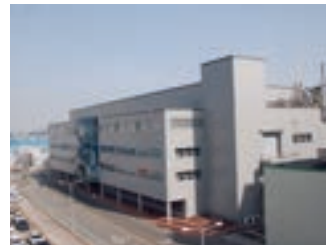
韓国のタッチセンサーパネル製造プラント
