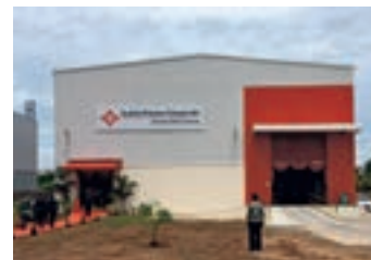
新設したPPコンパウンド工場（インド）
