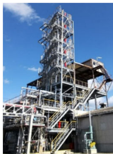
④ ケミカルリサイクル実証設備
