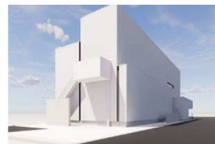
S-RACMO 第2系列（建設中）
