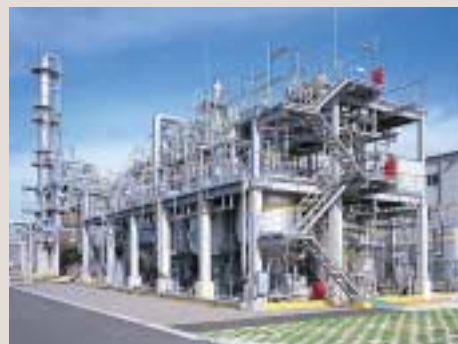
ゴム用老化防止剤「アンチゲン®6C」製造設備
