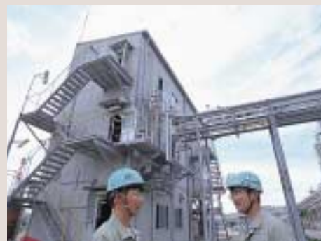
塩酸酸化の試験製造設備
