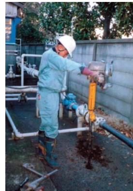
第13図 SCSCボーリング
