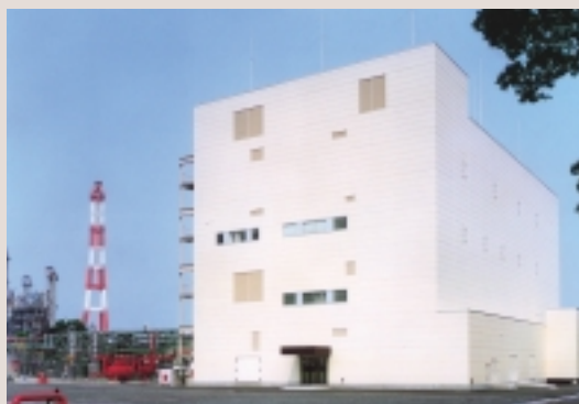
新原薬製造設備
