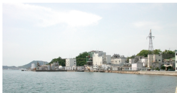
岡山プラント
