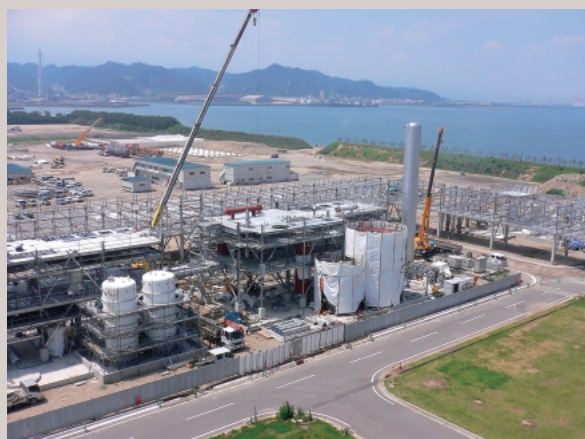
メチオニン製造設備増強工事 (2009年7月撮影)
