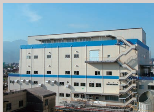
愛媛工場に増設した高純度アルミナ製造プラント
