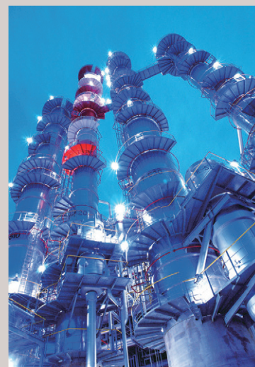
技術供与するプロピレンオキシドプロセスのプラント
