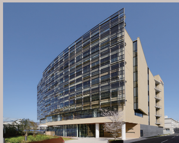
グローバルな研究開発の拠点として開設した健康・農業関連事業研究所の合成研究棟 (Chemistry Research Center) (兵庫県宝塚市)
