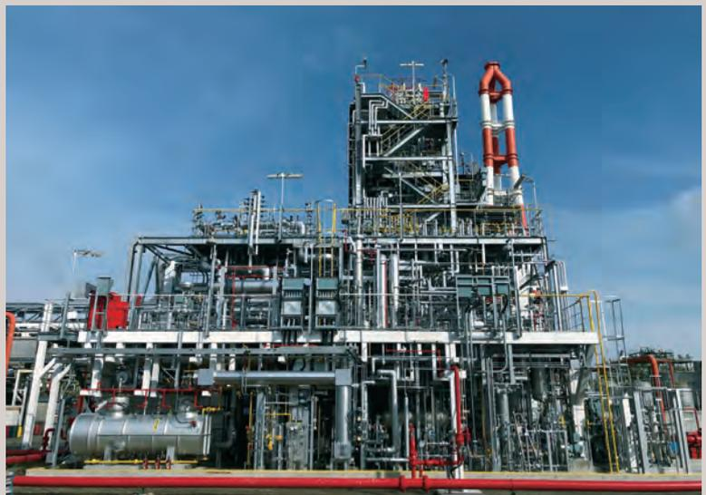
千葉工場に新設したエタノール脱水エチレン試験製造設備
