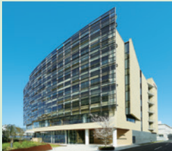
グローバルな研究開発のための創業・イノベーション拠点である健康・農業関連事業研究所合成研究棟「ケミストリーリサーチセンター」
