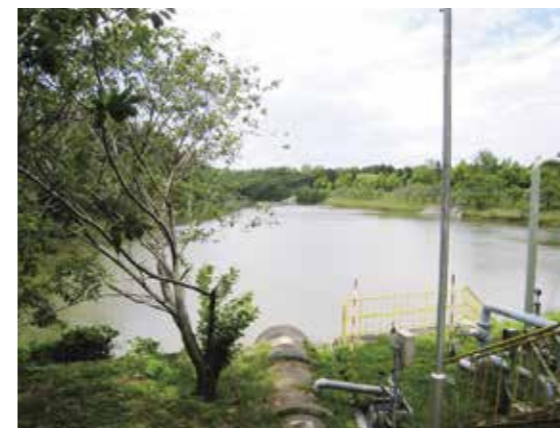
調整池(桜ヶ池)
