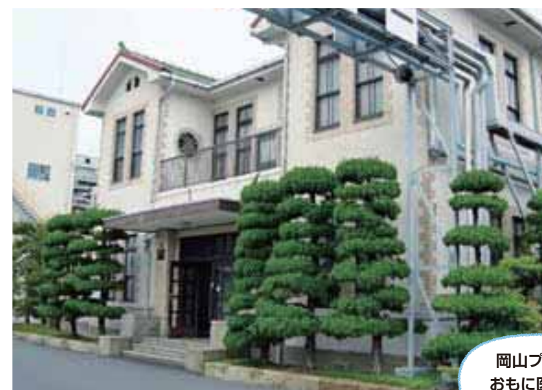
本館事務所(1915年建築)
