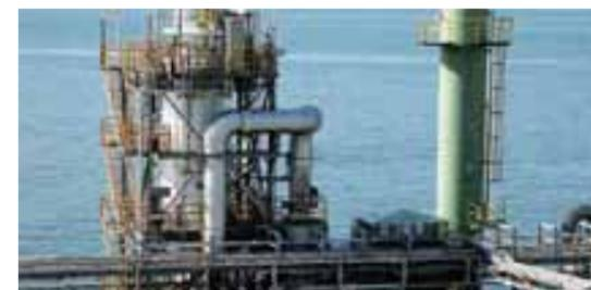
排水処理施設で処理することが困難な廃液を焼却処理する設備です。高温で燃やすことで完全燃焼させて廃棄物の減量化を図っています。(P10の液中燃焼処理を参照ください。)
