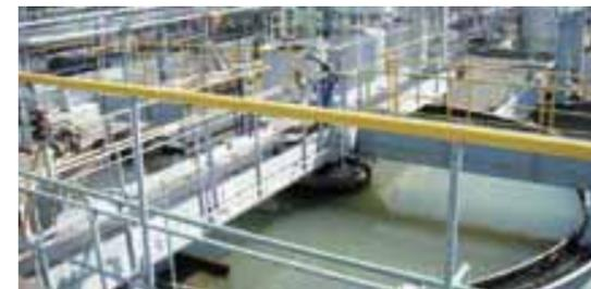
工場から出る排水を活性汚泥処理する設備です。水域への排出量を減らすよう努力しています。(P10の排水処理を参照ください。)
