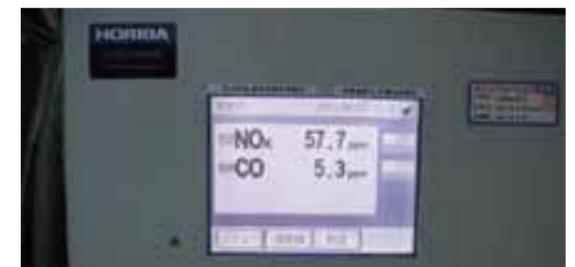
廃液焼却設備から排ガスのNOxを低減するため、アンモニア水添加燃焼による脱硝技術を導入しています。安定的に脱硝効果があることを確認するために連続測定機器を設置して常時監視しています。
