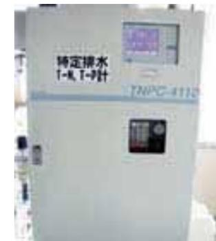
排水処理施設および廃液焼却設備で処理された排水の窒素・りんなどを連続監視する機器です。処理後の排水が無害であることを確認しながら海域へ放流しています。
