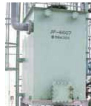
有機化学物質・臭気成分などを活性炭で吸着処理して除去する設備です。排ガス処理施設に設置して大気への排出量を減らすよう努力しています。
