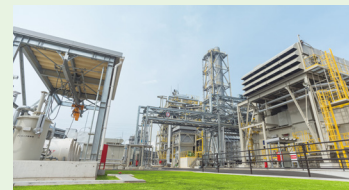
新居浜北火力発電所
