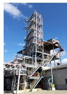
PMMAケミカルリサイクル 実証設備
