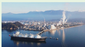
新居浜LNG基地と愛媛工場
