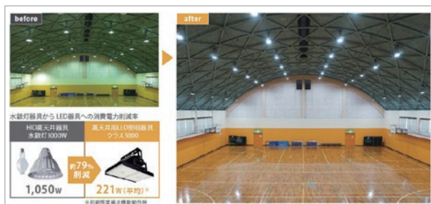
構内LED化事例 工場内体育館照明更新
