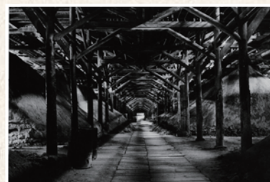
過磷酸石灰90間倉庫
